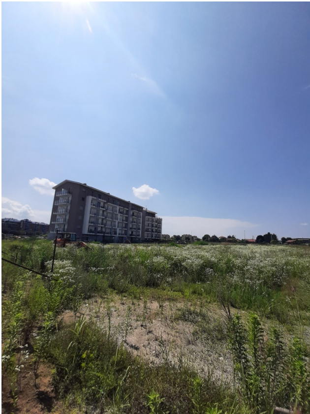
Vista verso Sud-Est
